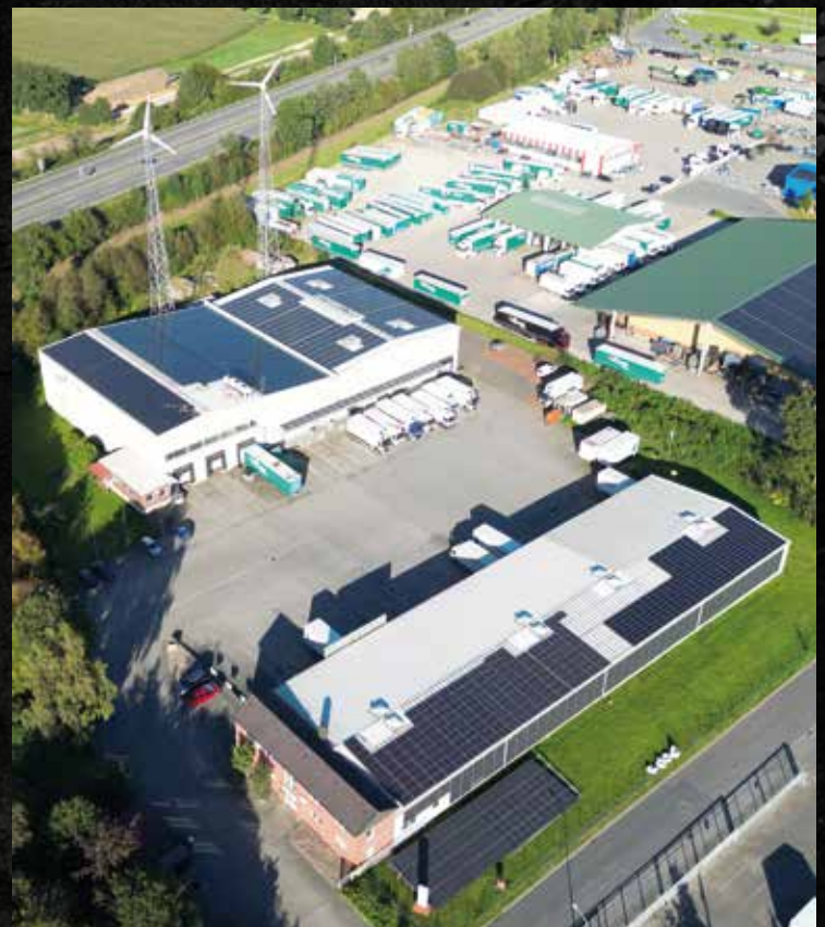
Luftbild der Niederlassung Nortmoor mit Photovoltaik- und Windkraftanlage
